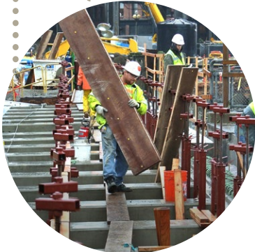
新海滨的地基
